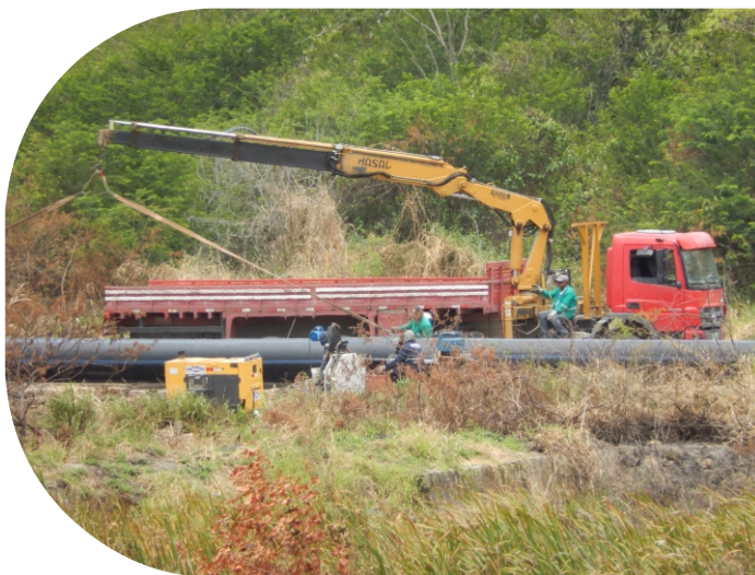
Adutora terá 18,38 km de extensão
