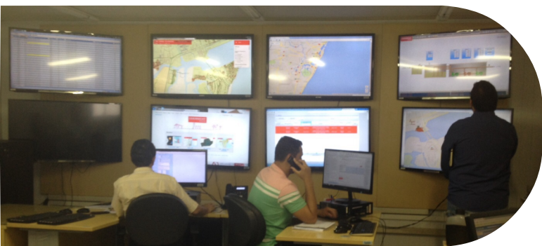
Centro de Controle Operacional no Cabanga
