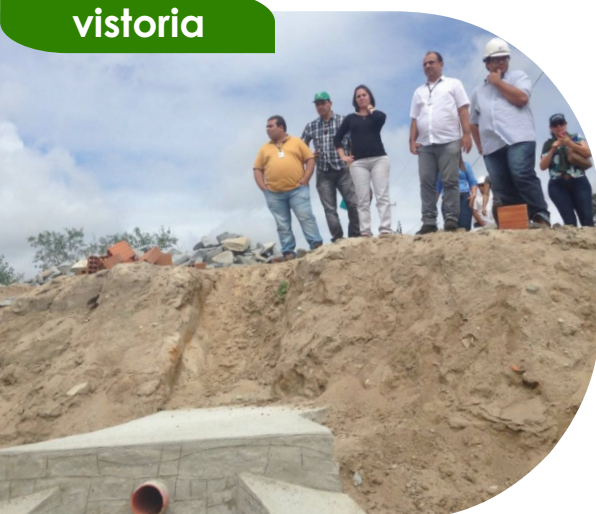
Compesa e CPRH em vistoria às obras do SES Tacaimbó
