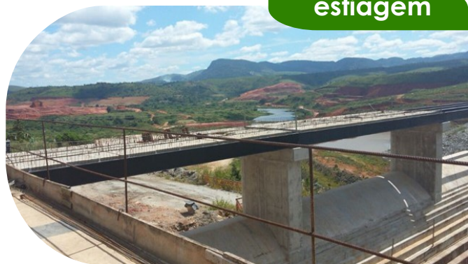
Barragem Serro Azul, construída em Palmares
