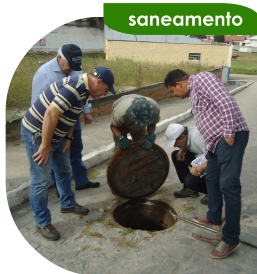
As equipes abriram alguns Poços de Visita para verificar as condições de operação do coletor
