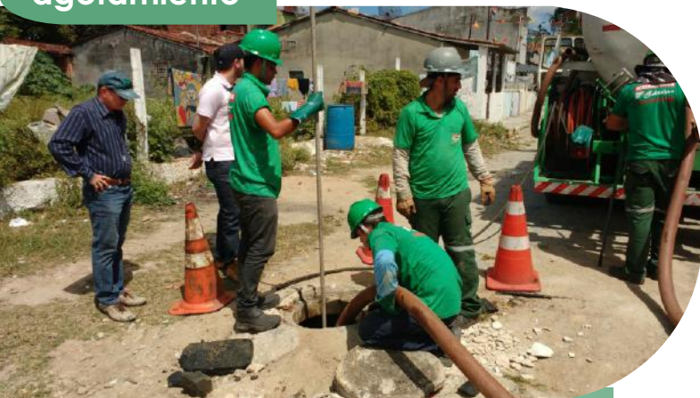
Equipo comenzó los trabajos de limpieza de red existente
