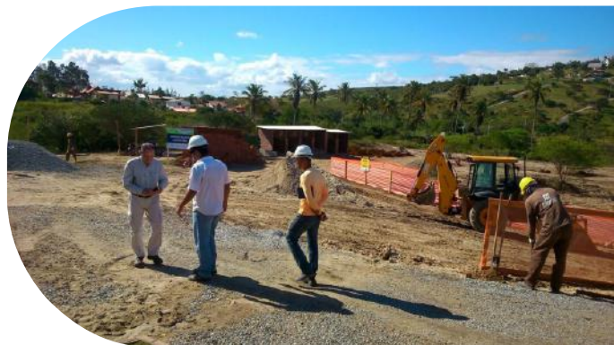
La obra de construcción del SES Gravatá también fue parte de la secuencia de comandos
