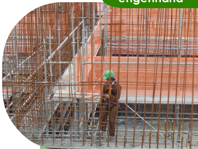
Construção da Estação de Tratamento de Esgoto
