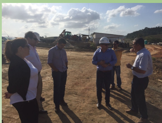
Estação elevatória do Sistema Pirangi, em Catende
