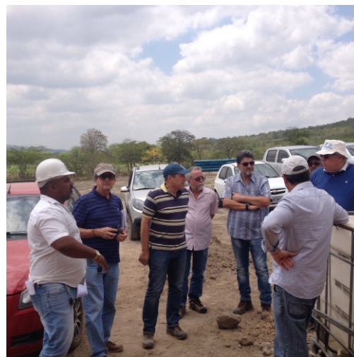
Equipe no canteiro do obras
