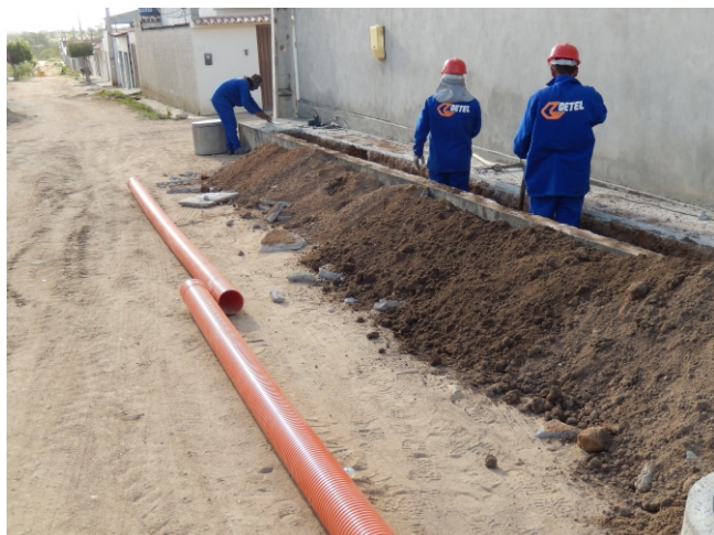
Operários implantam a rede coletora de esgoto
