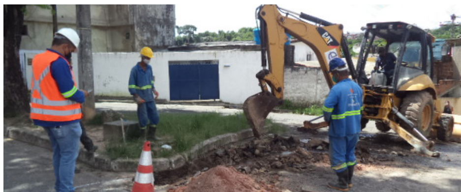
Substituição de rede para Estação Elevatória da Rua 12 no Curado I
