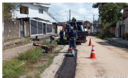
Implantação de alimentador secundário em Vista Alegre – Jaboatão dos Guararapes
