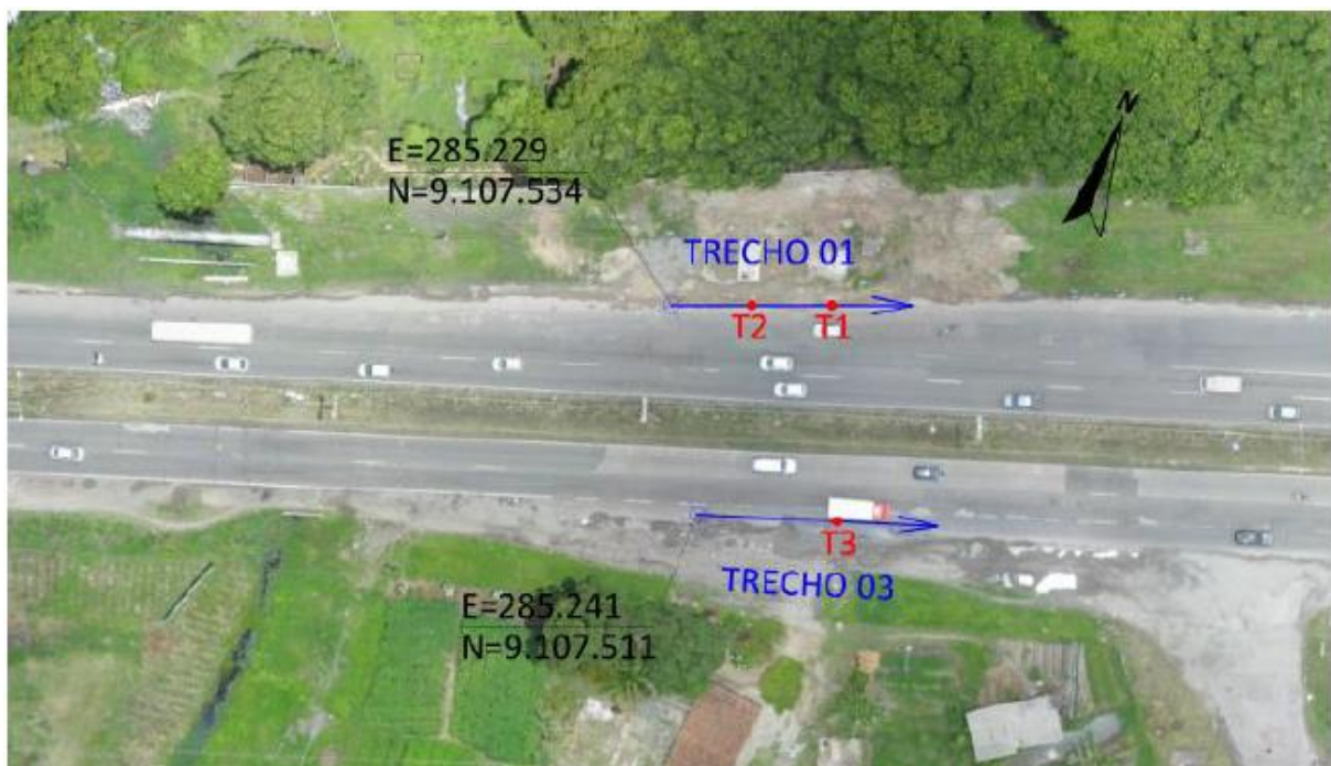
Figura 24 – Trechos 01 e 03 do levantamento por GPR
