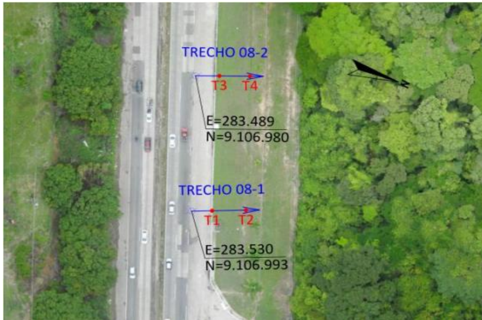
Figura 37 – Trechos 08-1 e 08-2 do levantamento por GPR
