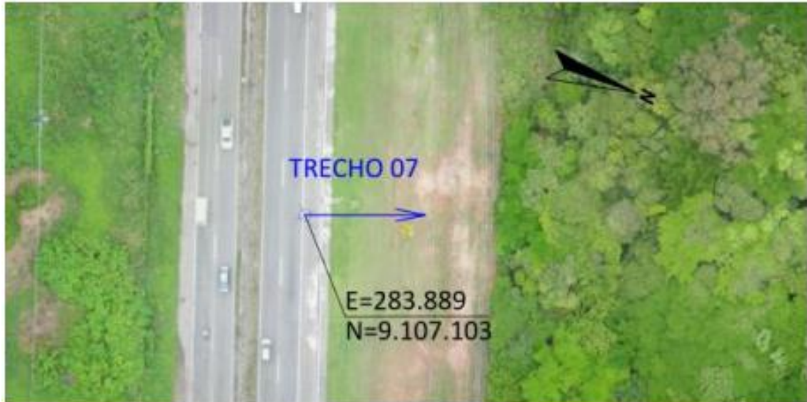
Figura 32 – Trecho 07 do levantamento por GPR
