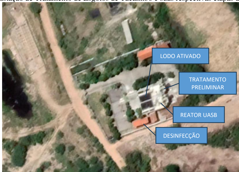
Figura 6 - Estação de Tratamento de Esgotos de Tacaimbó e suas respectivas etapas de tratamento
