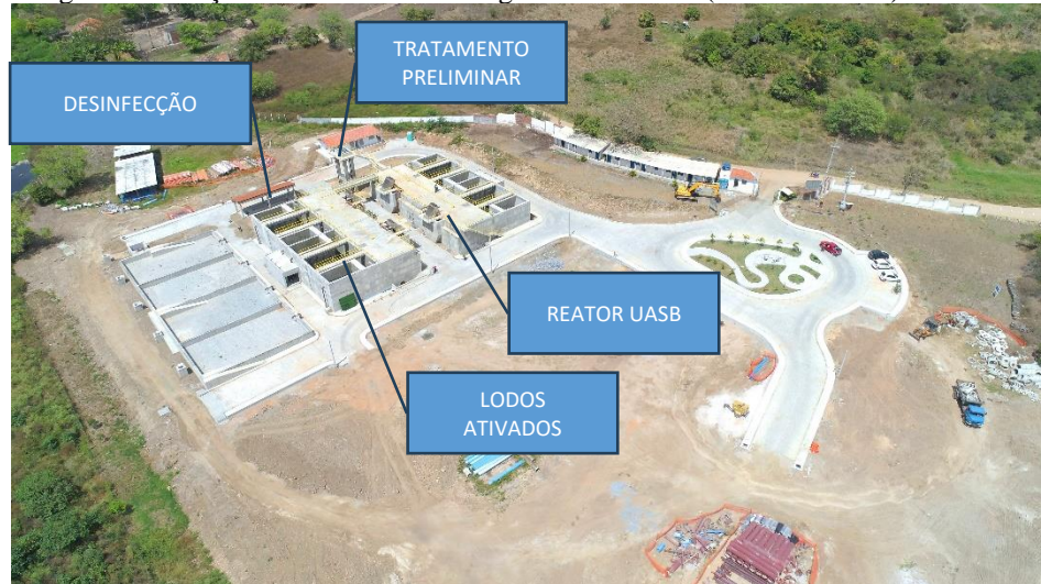
Figura 8 - Estação de Tratamento de Esgotos de Gravatá (ETE – Gravatá)
