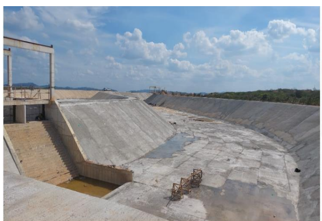
Foto 8 - Conclusão do reservatório ( V=70.000\text{ m}^3 )
