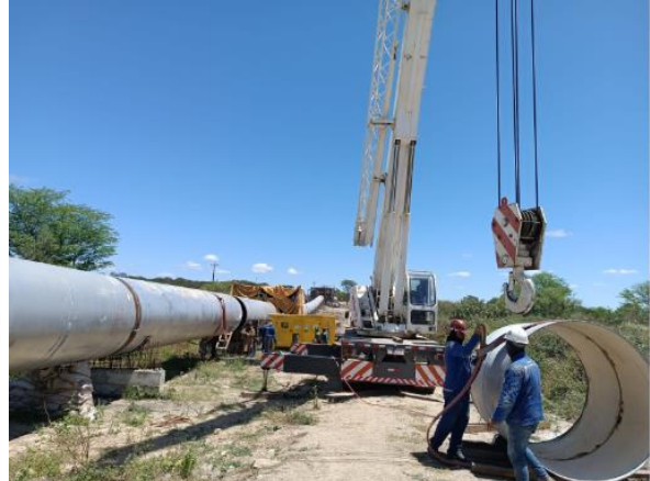
Foto 4 - Trecho aéreo da adutora (recalque)
