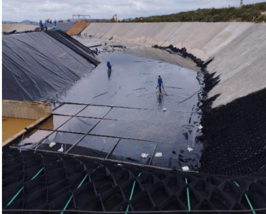
Foto 7 - Execução do reservatório de água bruta
