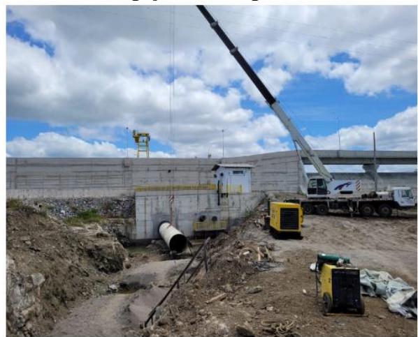
Foto 2 - Interligação na barragem
