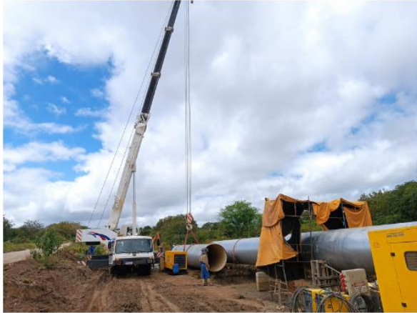
Foto 3 - Implantação da adutora
