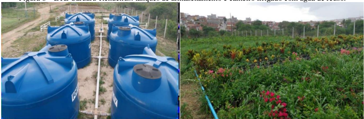
Figura 8 – ETE Caruaru-Rendeiras: tanques de armazenamento e canteiro irrigado com água de reúso.
