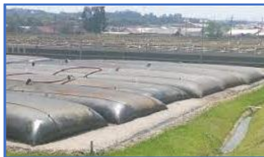
Figura 8- Bateria de geotexteis aplicada para grandes vazões
