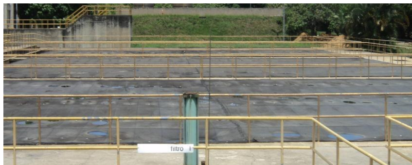
Figura 1.2 Foto do Tanque de Decantação da ETA Botafogo
