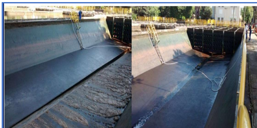
Figura 4 - LIMPEZA DOS RESÍDUOS GERADOS EM DECANTADORES CONVENCIONAIS
