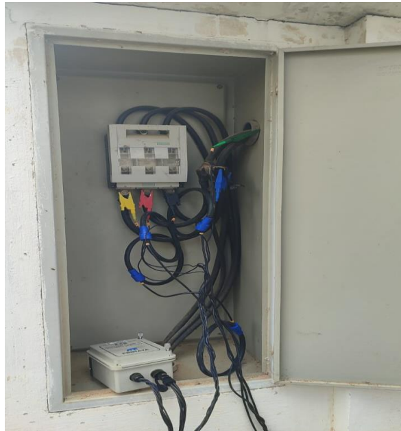
Figura 8 - Instalação do medidor em uma das unidades da Compesa
